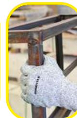
INSTALACIÓN DE ESTRUCTURAS
